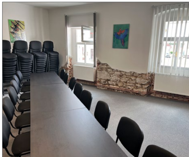
Rekonstrukce sálu v ZUŠ
