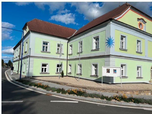
Oprava fasády a prostoru před ZUŠ
