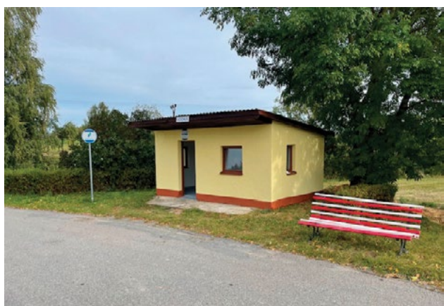
Opravy autobusové čekárny Vědná u trafostanice
