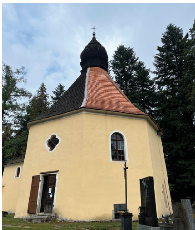
I. etapa opravy střechy kaple sv. Máří Magdaleny
