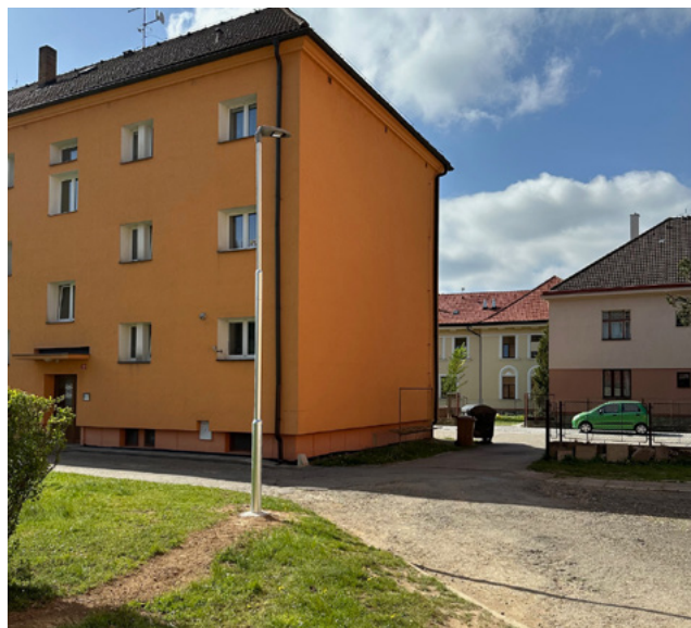
Vybudování veřejného osvětlení v ulici Tyršova – „Rafanda“.
