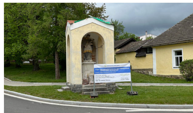
Oprava kapličky sv. Jana Nepomuckého na okružní křižovatce.
