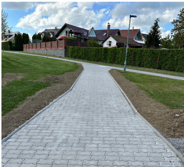
Vybudování spojovacího chodníku v Tábořské ulici.
