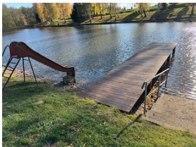
Oprava mola a zábradlí na koupališti
