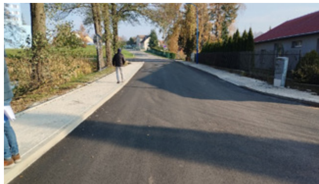
Rekonstrukce ulice U Nádraží včetně opravy vodovodu – 24,2 mil. Kč (dotace 8 mil. Kč)
