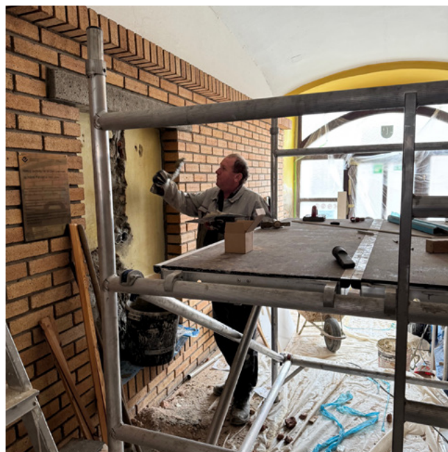
Stavební úpravy vestibulu v budově MěÚ
