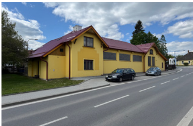
Provedena oprava střechy spodních garáží na Technickém dvoře v Komenského ulici, která byla v havarijním stavu. Práce provedla firma Pokrývačství Michal Štangel z Kamenice nad Lipou.
