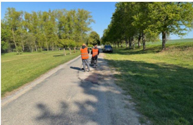
Byly zahájeny práce na opravách výtluků na místních komunikacích ve městě firmou Gustav Hasnedl z Nové Včelnice.
