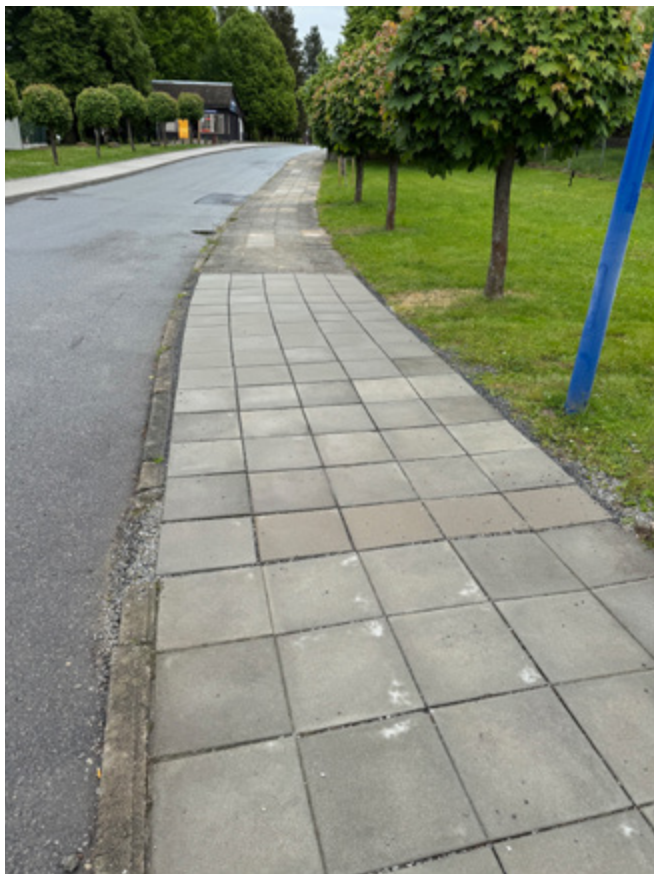
V ulicích Na Besídce a V. Nováka byly provedeny opravy chodníků.
