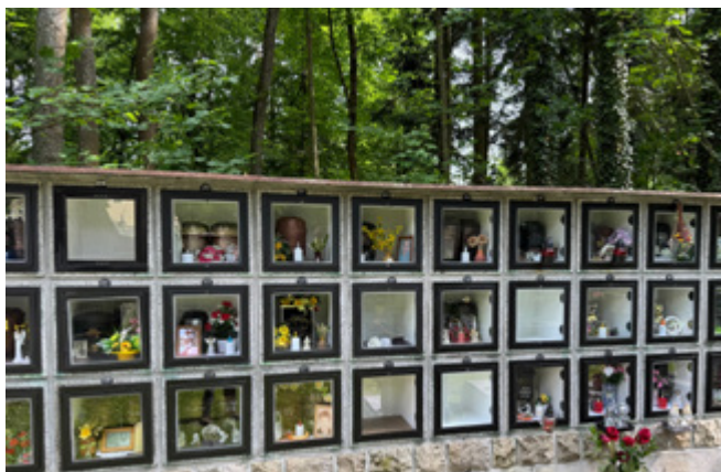
Na hřbitově Bradlo byla provedena oprava urnových schránek, které jsou připraveny k pronájmu.
