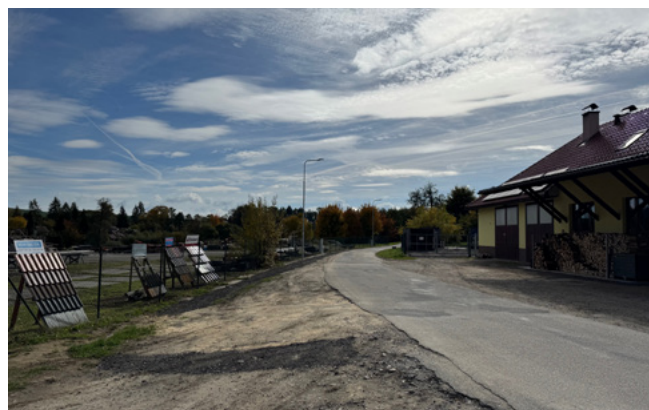
Výměna veřejného osvětlení v ulici U Nádraží.
