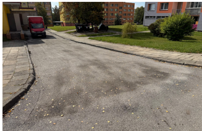
Oprava místní komunikace na sídlišti Za Kult. domem.
