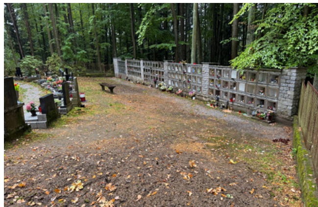
Odstranění pařezů v urnovém háji na hřbitově Bradlo.
