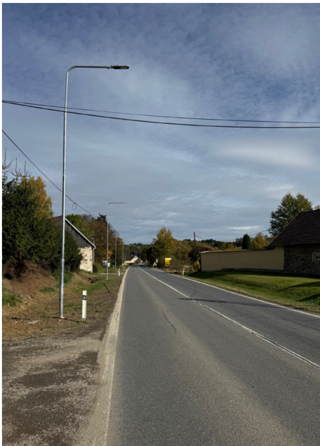
Výměna veřejného osvětlení podél silnice I/34 v místní části Pravíkov.
