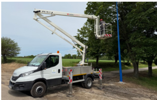
Výstavba veřejného osvětlení v Pelhřimovské ulici
