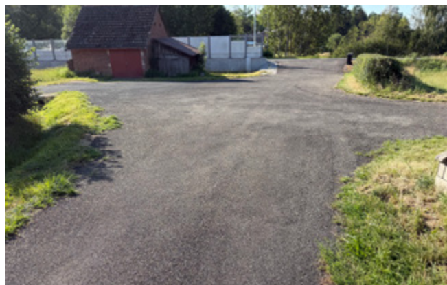
Bezprašná úprava komunikace v místní části Pravíkov
