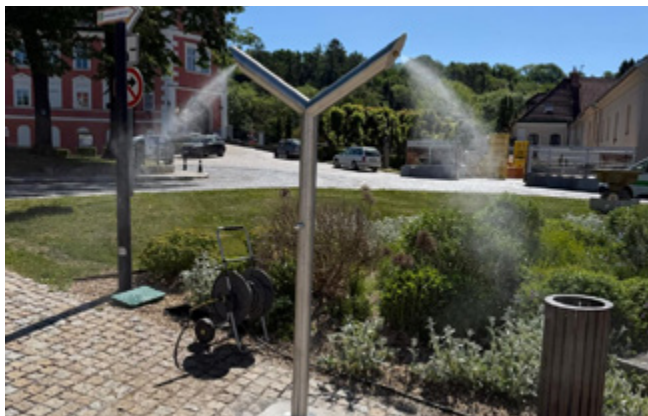
Instalace mlžítka na náměstí Čsl. armády
